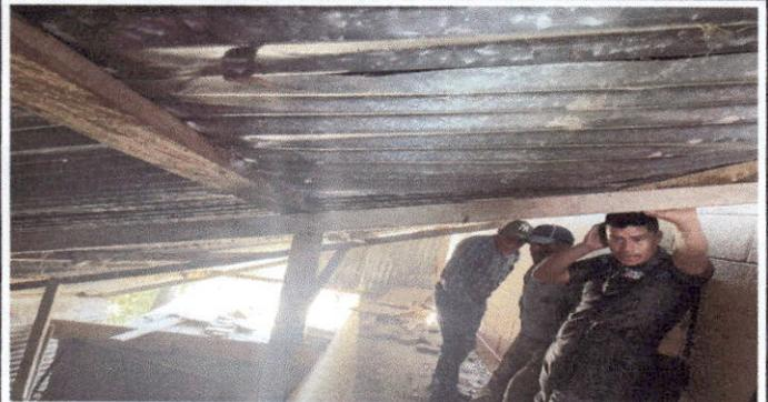
Foto 2: Cubierta en mal estado
